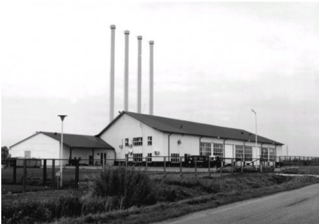
Ryc. 1. Ciepłownia geotermalno - gazowa w Pyrzycach, o mocy szczytowej 48 MW t Fig. 1. Geothermal heating plant with peak-load gas burners in Pyrzyce. Output power 48 MW t
